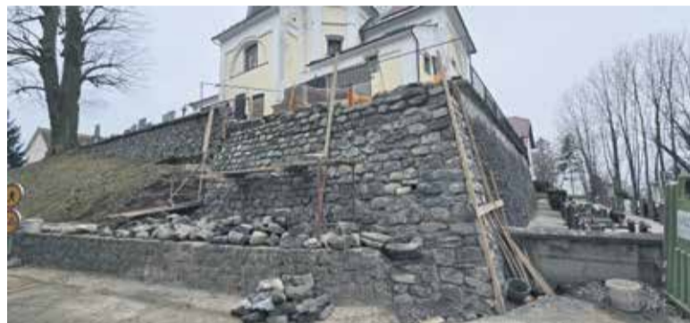
Sanacijska dela na pokopališkem zidu na Homcu dobro napredujejo.
