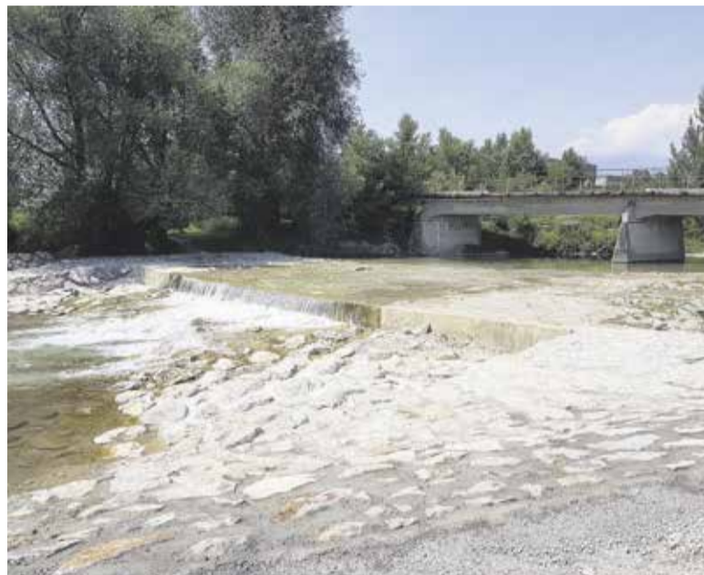
Protipoplavni ukrepi na Kamniški Bistrici pri železniškem mostu na Količevem
