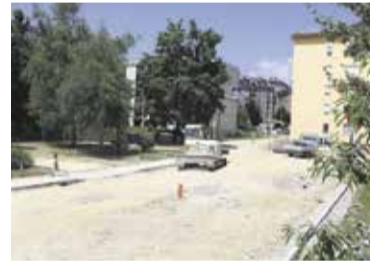
Dela na Župančičevi ulici
