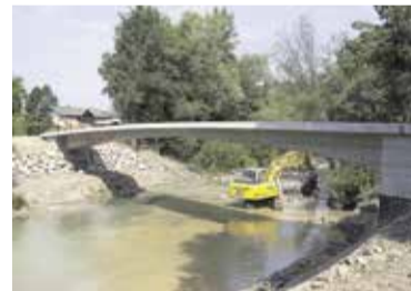
Gradnja Mlinarske brvi v Radomljah
