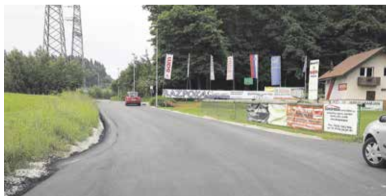
Končujemo z drugo fazo rekonstrukcije ceste Krumperk – AC
