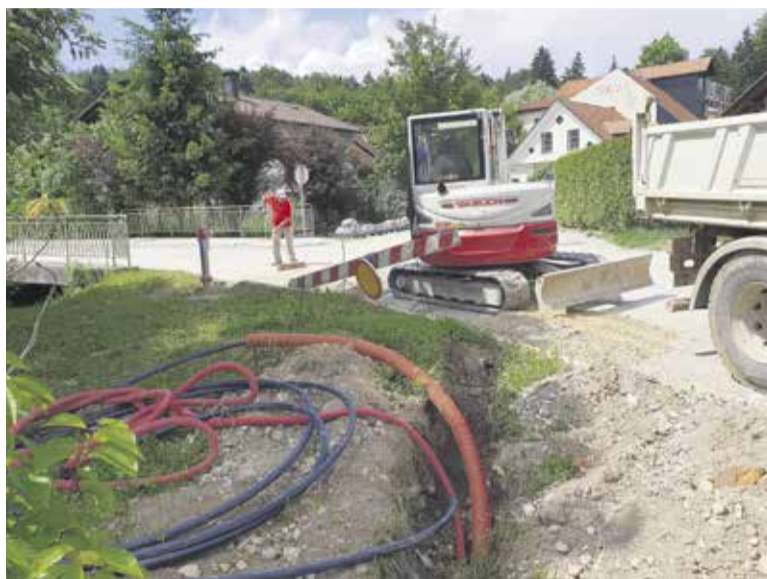
Prenova vodovoda na Homcu
