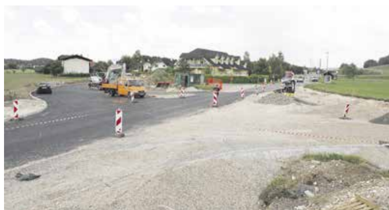
Rekonstrukcija križišča v Krtini
