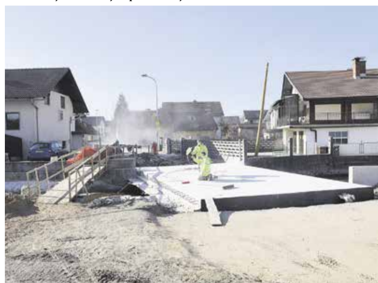
Na Podrečju poteka gradnja nadomestnega mostu čez mlinščico.
