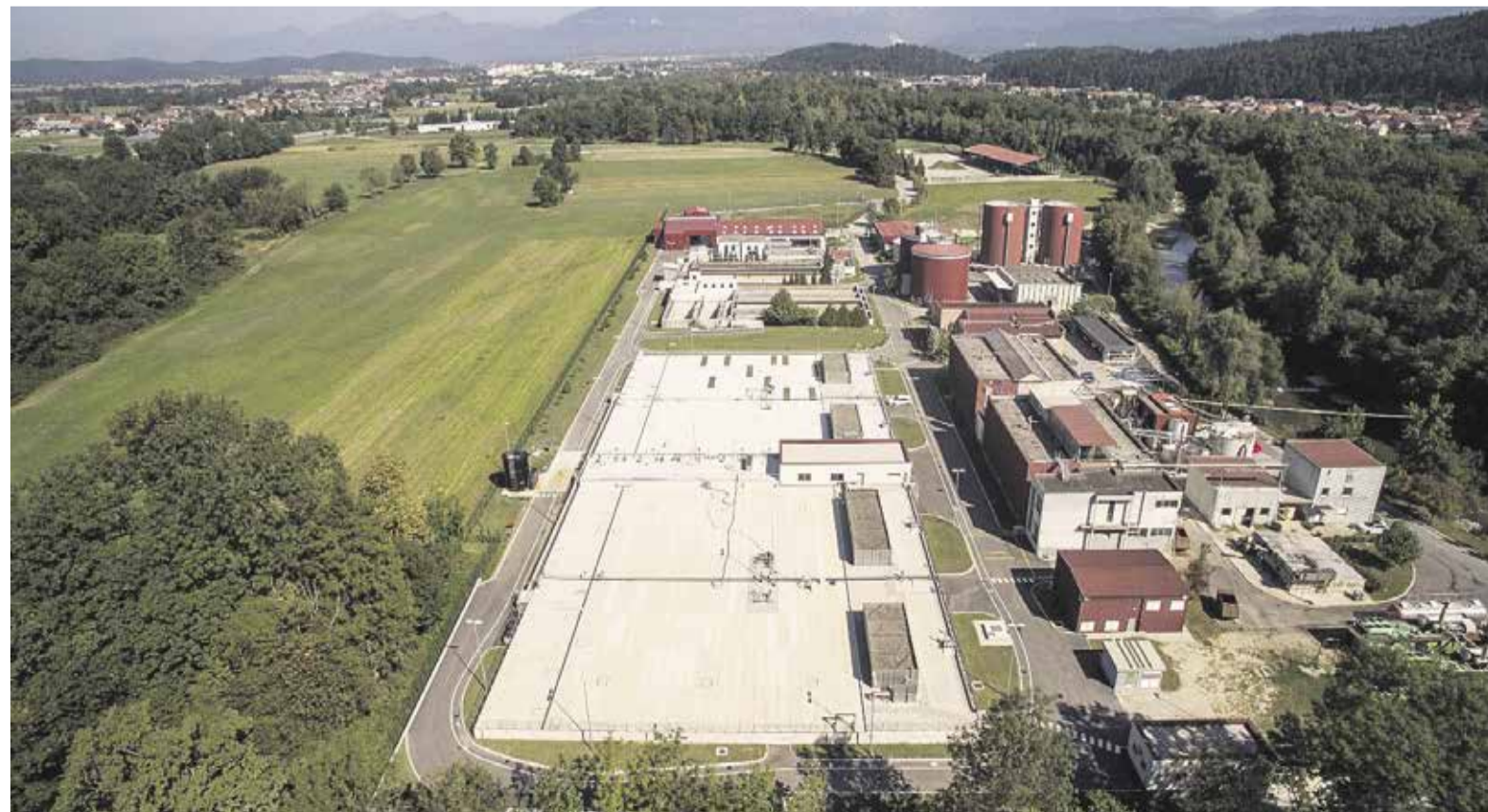
Centralna čistilna naprava Domžale - Kamnik po nadgradnji 2016
