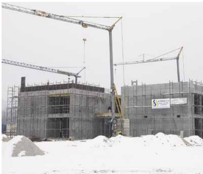
Gradnja POŠ Ihan napreduje po načrtu in bo predvidoma zaključena do jeseni 2017.
