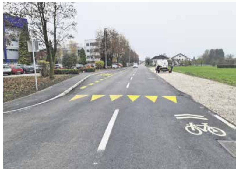
Zaključujemo z gradnjo zgornjega dela ceste skozi Količevo.
