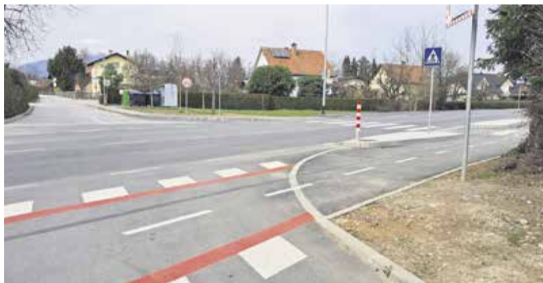
Nepregledno križišče ob vključevanju s Taborske ceste
