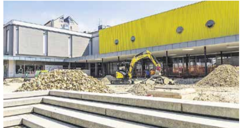
V času gradnje bo dostop s sprednje strani nekoliko spremenjen in označen.
