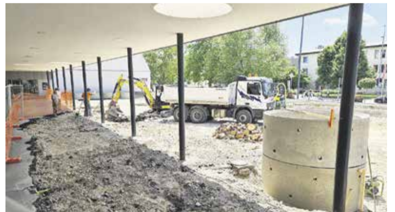
Dela na ploščadi pred veleblagovnico
