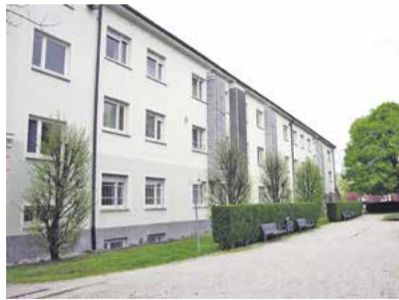
Stavba Občine Domžale s strani parka
