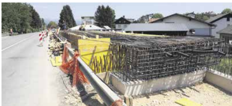
Gradnja kolesarske steze lepo napreduje.
