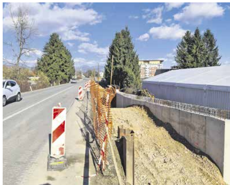
Gradnja Regionalne kolesarske povezave
