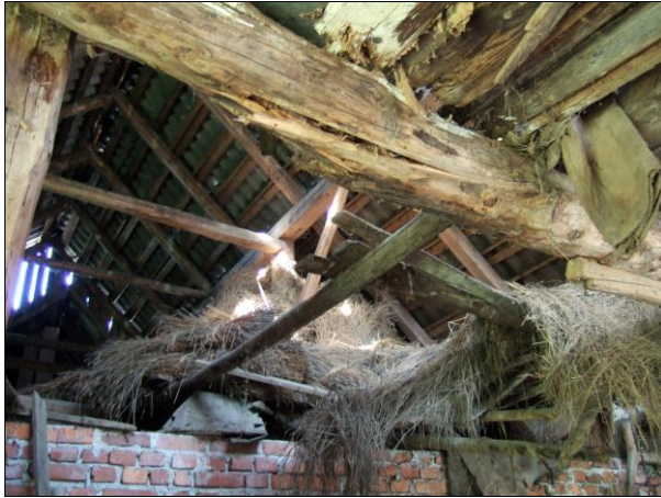
Slika 26: Ostrešje lope in hleva. Foto: Saša Roškar, arhiv ZVKDS OE Kranj.
