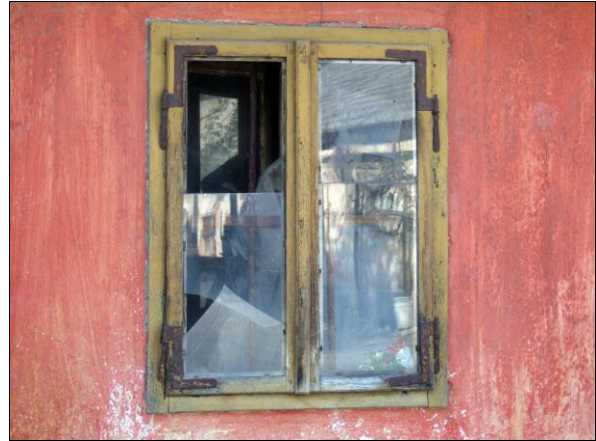
Slika 22: Škatlasto okno v kamnri. Foto: Saša Roškar, arhiv ZVKDS OE Kranj.
