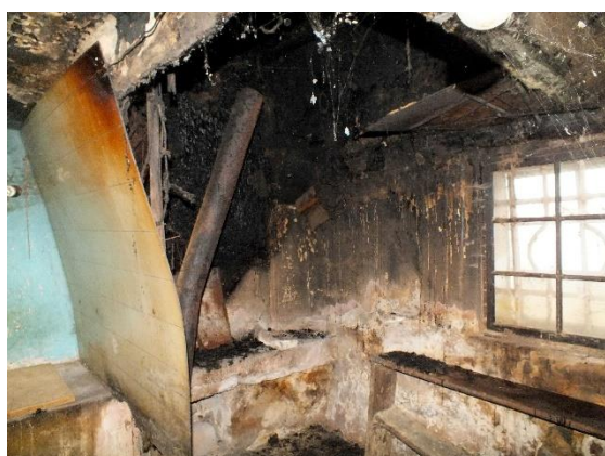
Slika 9: Tanka stena je ločevala zidan štedilnik od črne kuhinje. Dimnik je bil speljan pod velb. V kotu je stal svinjski kotel, poleg njega pa polica za lonce.
