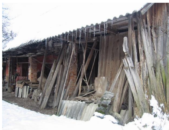
Slika 36: Pogled na šupo in lopo, ki je danes ni več.
