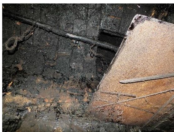
Slika 10: Pod dimnikom je bil kovinski pokrov, ki je lovil saje z dimnika, da niso padale na tla.
