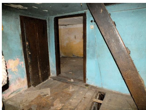
Slika 12: Pogled proti shrambi in cimru z veže. Pod stopnicami je pokrov, ki pokriva vhod v klet.
