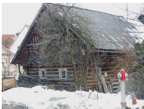
Zahodni del Kofutnikove domačije je grajen iz zaobljenih brun. V zgornjem delu je zatrejni gank.
