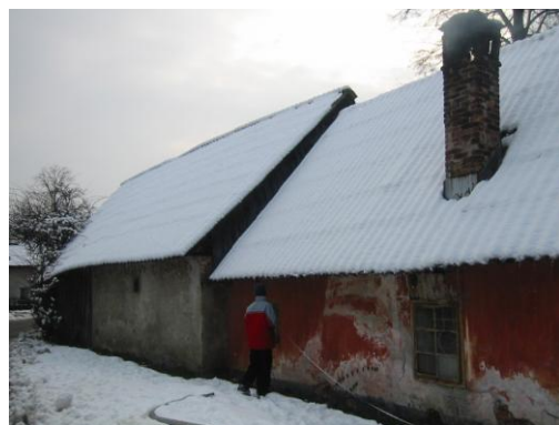
Osrednji del Kofutnikove domačije s severne strani. Na desni je okno od kamre, naprej je kasneje pozidan hlev.
