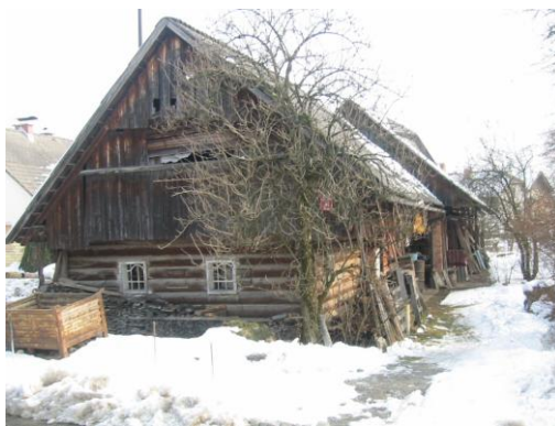
Zahodni del Kofutnikove hiše je v celoti lesen. Nad okni je navidezen ali zatrepn gank.
