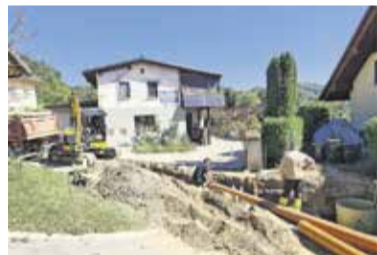
Nadaljevanje gradnje kanalizacijskega omrežja na Goričici pri Ihanu.
