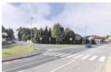
Končana prenova Igriške ulice
