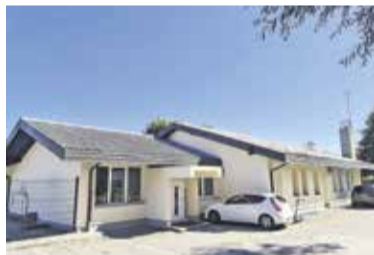
Sanacija vrtca Kekec v Radomljah je zaključena.
